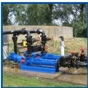
Перекачивающие насосы для осадка на станции обработки сточных вод
